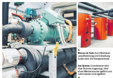
Das (grüne) Herz. Der Wärmetauscher macht in einem hermetisch abgetrennten System Heizen und Kühlen möglich.
