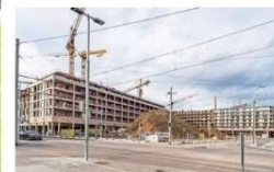
Die Baustelle vor wenigen Monaten KILJÜRGEN FICHS
